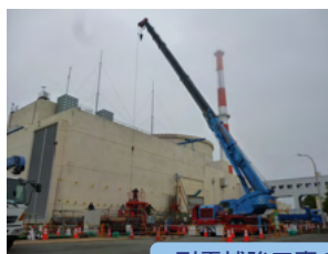
耐震補強工事の着手（地盤改良・掘削）
