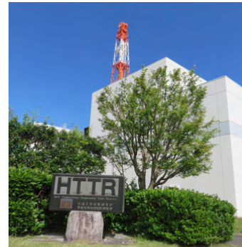
HTTR (高温工学試験研究炉)
