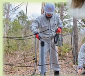
地下水モニタリング技術の確立に向けた検討
