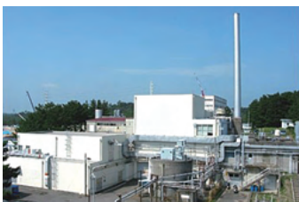
廃止措置中の再処理特別研究棟(原子力科学研究所)
