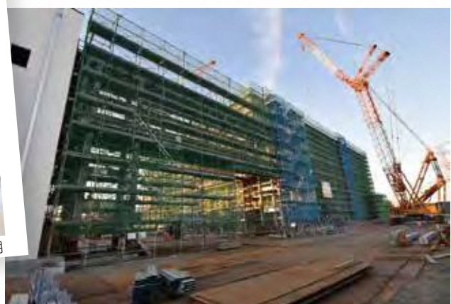
大熊分析・研究センター第1棟建設時の様子
